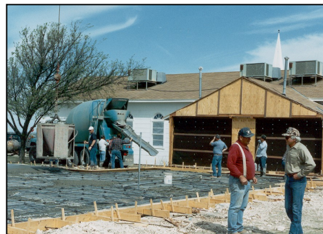
Pouring the foundation
